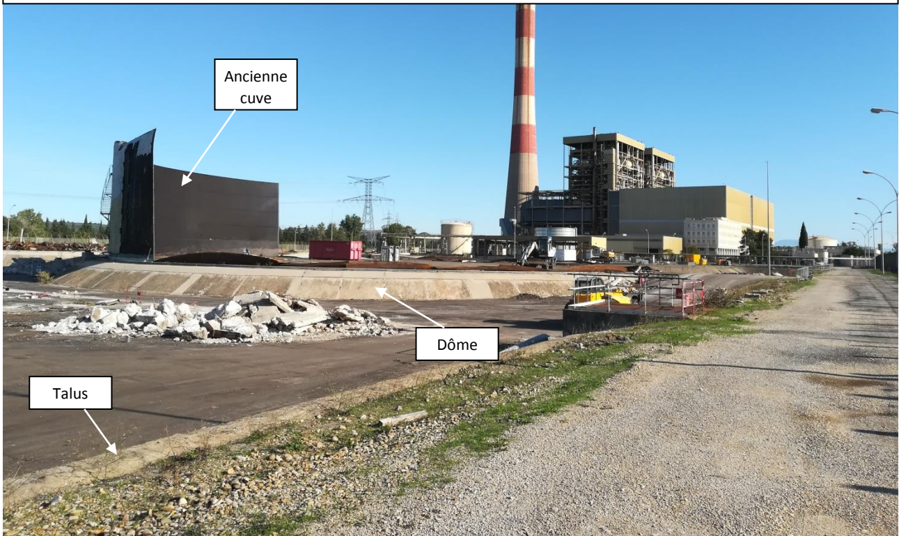
Figure 8- Site en cours de démantèlement – Octobre 2019
