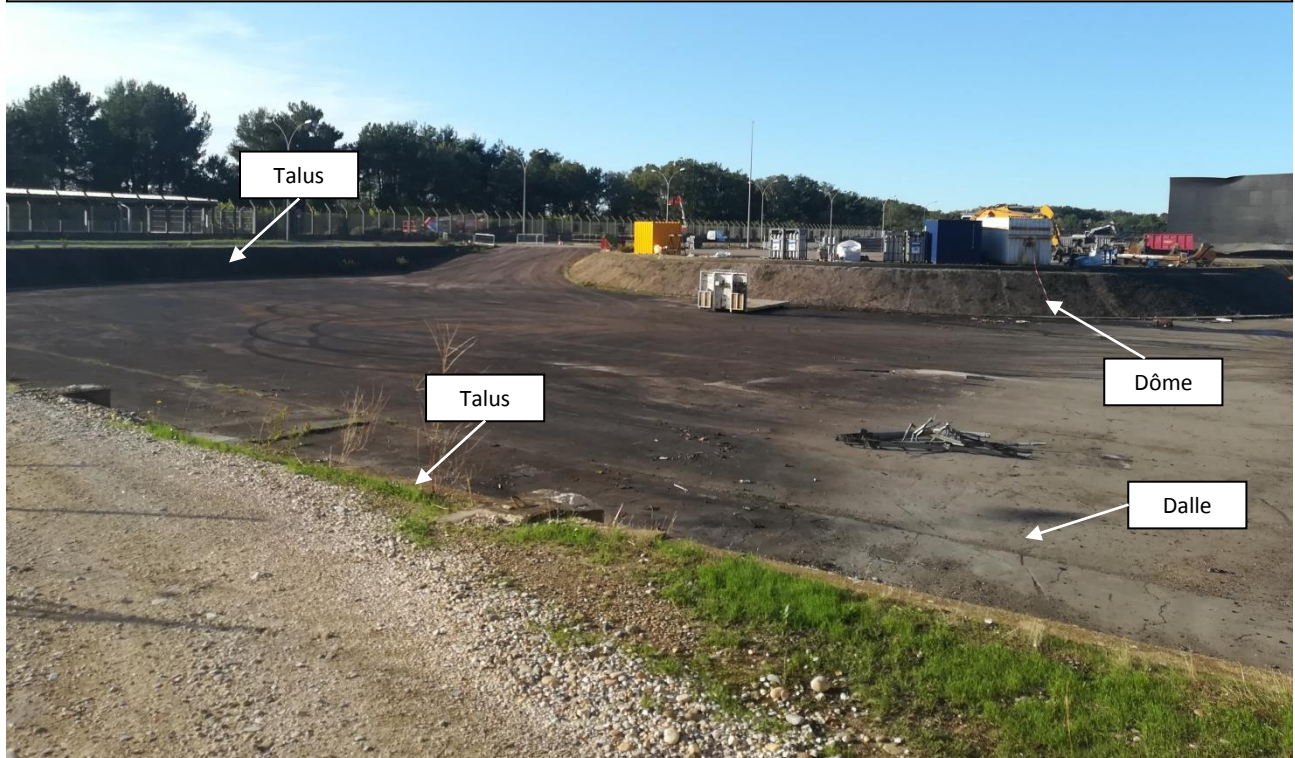
Figure 7- Site en cours de démantèlement – Octobre 2019
